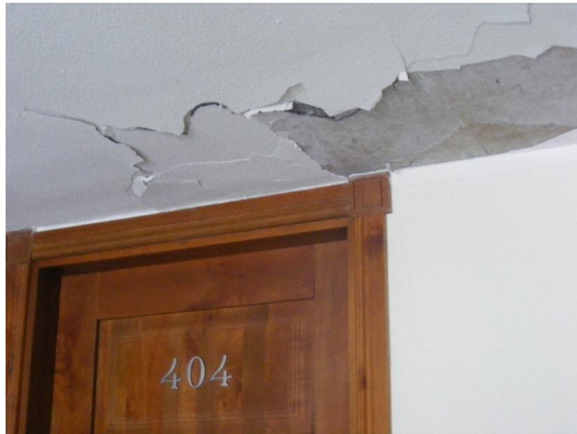
Figura 1.4: Daños en losa cercana a muros. Fuente: Universidad Católica de la Santísima Concepción.
