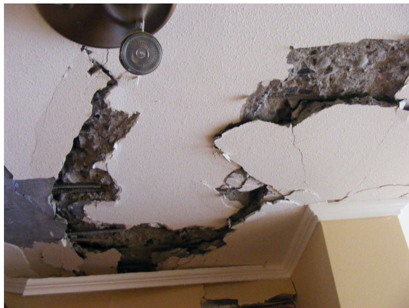
Figura 1.3: Daños en losa cercana a muros. Fuente: http://www.reclamos.cl .
