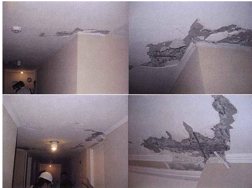
Figura 1.2: Daños en losa a nivel de esquinas de muro. Fuente: Inspección Post Sismo del 27 de Febrero del 2010 Edificio Don Manuel, realizada por Idiem.
