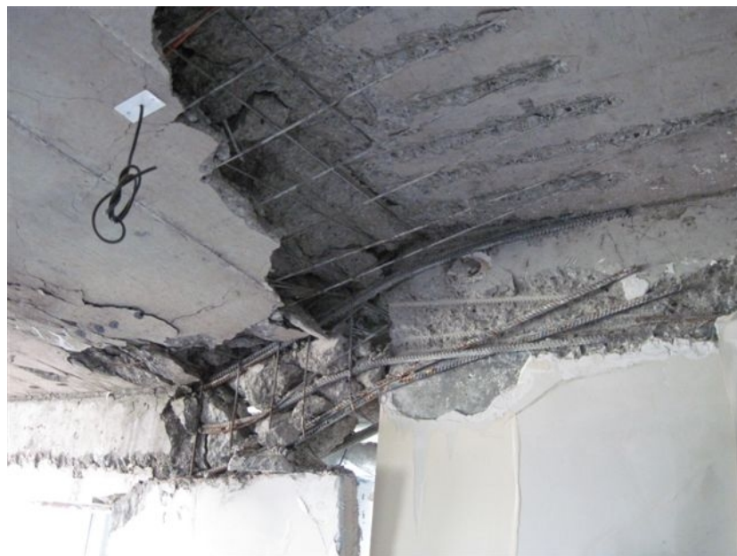
Figura 1.5: Daños en losa cercana a muros. Fuente: Universidad Católica de la Santísima Concepción.
